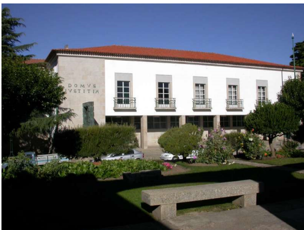
Edifício propriedade do Ministério da Justiça
