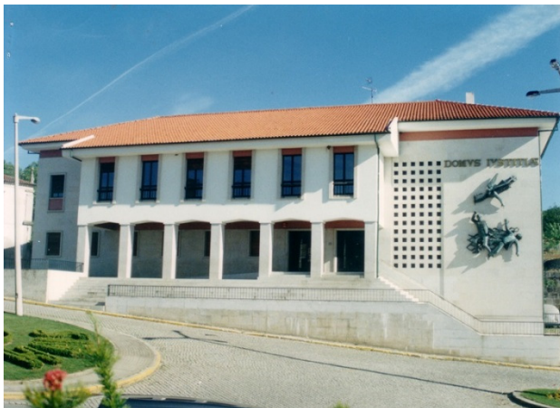
Edifício propriedade do Ministério da Justiça
