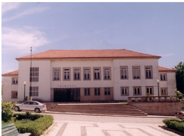
Edifício propriedade do Ministério da Justiça
