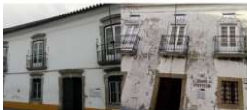
Edifício do TEP/TT
