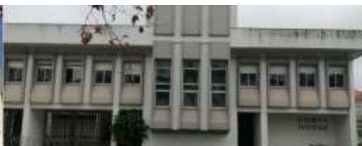
Palácio da Justiça de Montemor-o-Novo
